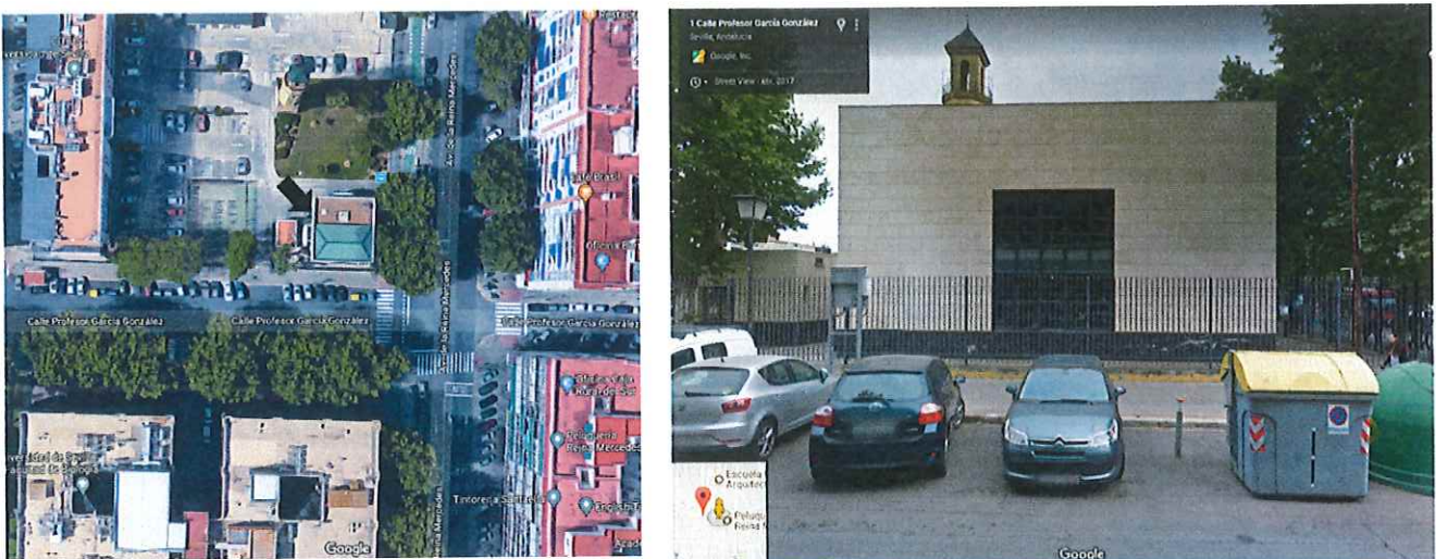
Figura 1. Imágenes aérea y frontal trasera del edificio.
